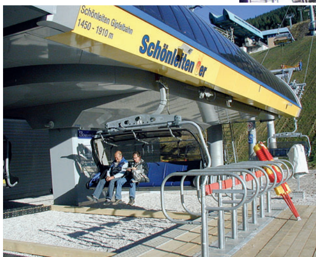
Die 6er-Sesselbahn „Schönleiten“ in Saalbach im Stadium der Abnahmeprüfung. Im Bild der 90°-Einstieg in der Talstation.
